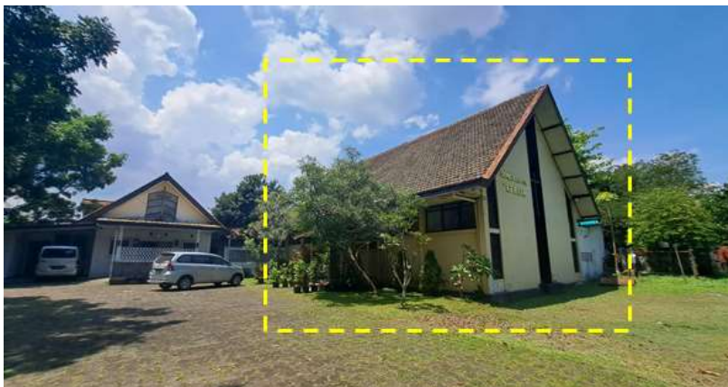
Gambar 2 Gedung Gereja Baptis Efrata Bandung (dalam kotak kuning) merupakan bangunan yang akan direnovasi.
