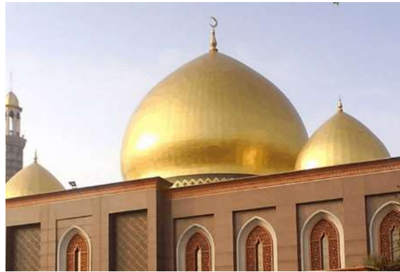
Gambar 3 Atap masjid Sumber: (kontraktorkubahmasjid.com 2020)
