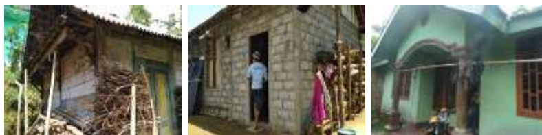
Gambar 3 a) Rumah tinggal dinding kayu; b) rumah tinggal berdinding batako; c) rumah tinggal berdinding plaster
