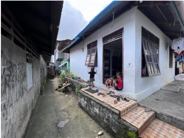
Gambar 4. Kondisi Bangunan di Lokasi Studi
