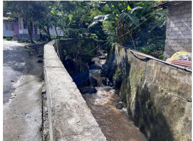
Gambar 5. Kondisi Drainase Primer di lokasi Studi
