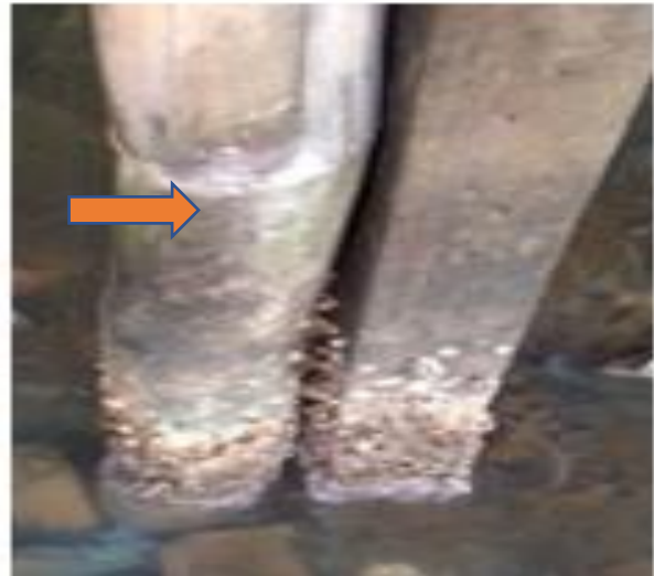
Gambar 5. Bambu sebagai fondasi dalam pada hunian di kawasan pesisir pantai kota Makassar.
