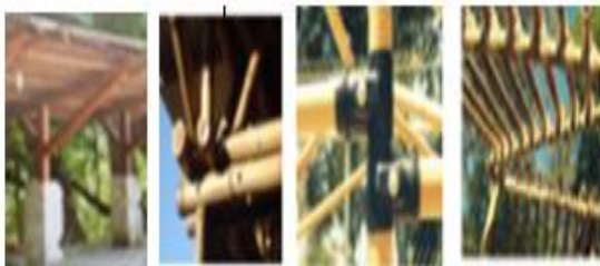
Gambar 18. Sistem konstruksi rangka atap dengan material bambu
