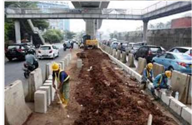
Gambar 10. Pelaksanaan Konstruksi Jalur LRT Layang Jabodebek
