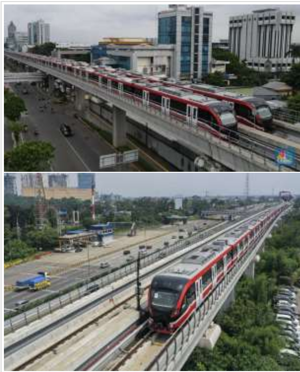
Gambar 11. Jalur rel LRT layang Jabodebek Sumber: (Rachman 2021)
