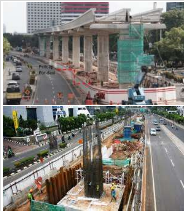
Gambar 14. Tiang pile cap ialah tiang penyangga Rel LRT Sumber: (LRT JABODEBEK 2018b)
