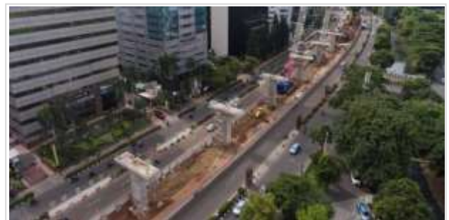
Gambar 13. Tiang penyangga Rel LRT yang melalui jalur hijau median jalan eksisting Sumber: (Liputan 6 2015)
