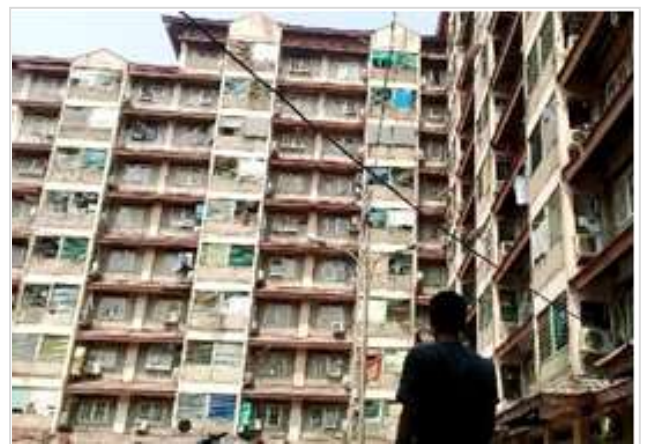
Gambar 8. Kondisi Rusunawa Klender
