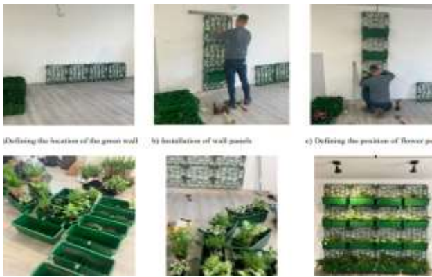
Gambar 13. Sistem green wall yang dipasang pada ruang kelas di Universitas Teknik Košice, Slovakia
